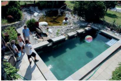
Die Wartung der Anlage beschränkt sich unter anderem auf den wöchentlichen Einsatz eines Poolroboters und mindestens zwei Rückspülungen des Filters pro Jahr beim Naturpool.
